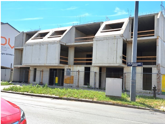
Mehr ein Denkmal als Baustelle - Frauenstiftgasse 6
