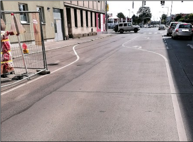
Für die Baustelle wurde der Fahrbahnverlauf geändert
