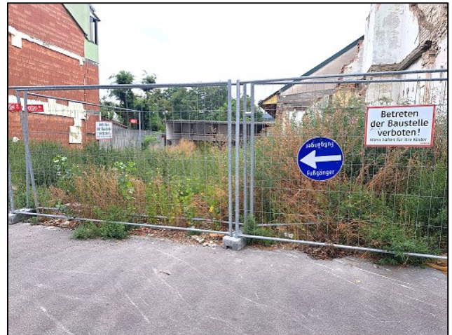
Die Baustelle in der Ruthnergasse 18 wächst langsam zu ...
