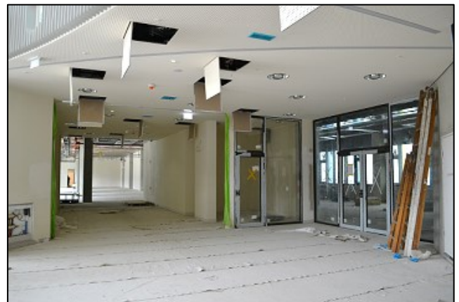
Geschäfte im Eingangsbereich entstehen
