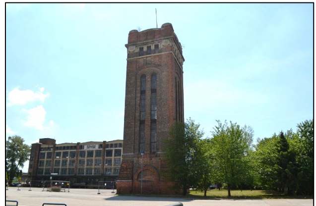
Ein Wasserturm diente einst der Wasserversorgung der Firmen
