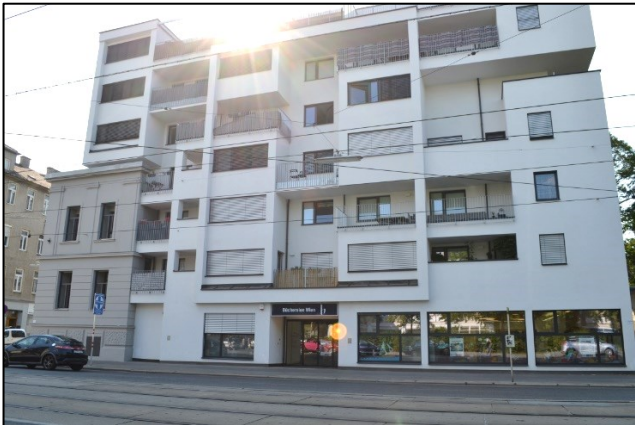
Vom Weisselbad blieb nur ein Teil der Fassade erhalten, der in den Neubau integriert wurde
