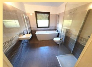
Das Bad nach der Sanierung
