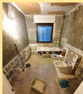
Das Bad vor der Sanierung
