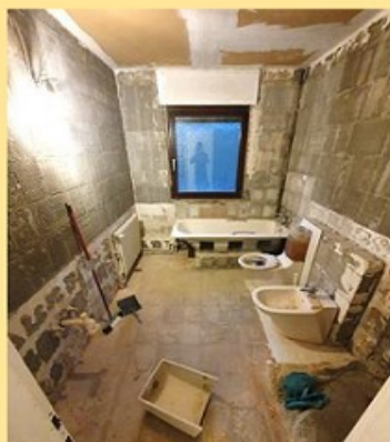
Das Bad vor der Sanierung
